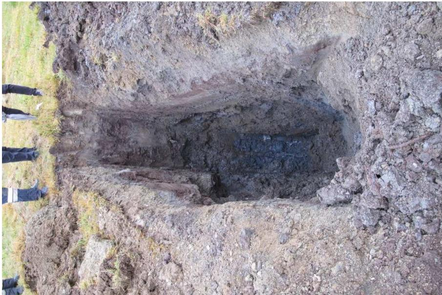
Abb. 1: Baggerschürfgrube S01/16 - Aushubsohle bei -3,8 m ( Foto: GDP ZT GmbH)
